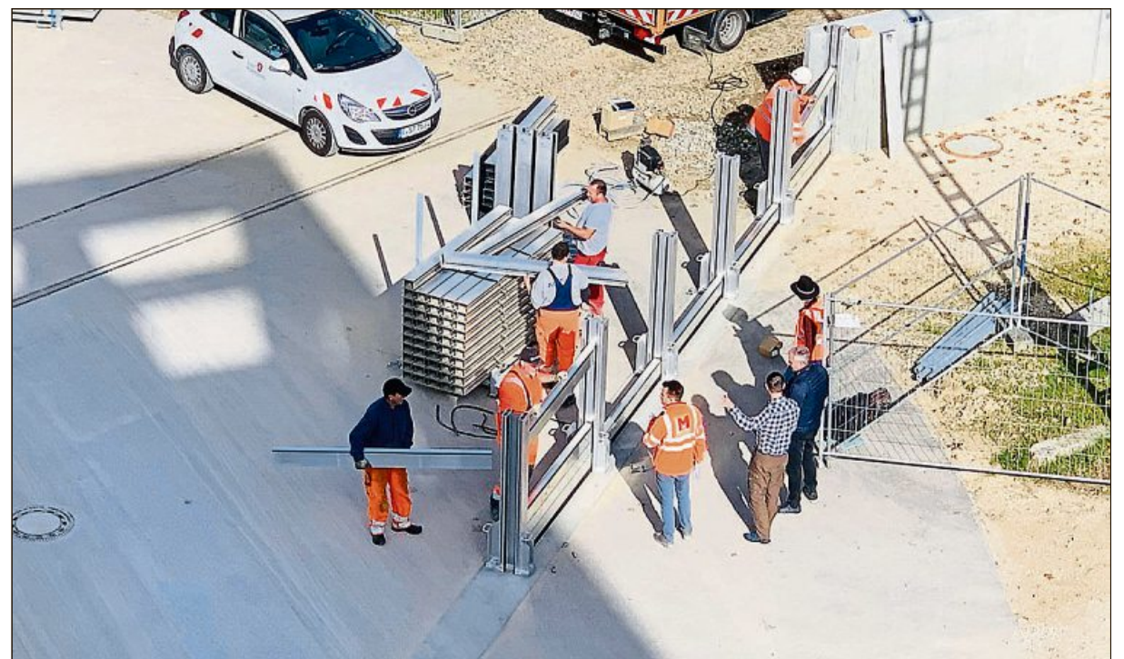
Drainage mit Filterkies und Probeaufbau der mobilen Elemente.
