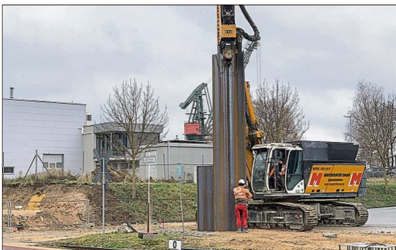
Einbringen der Spundwand.
